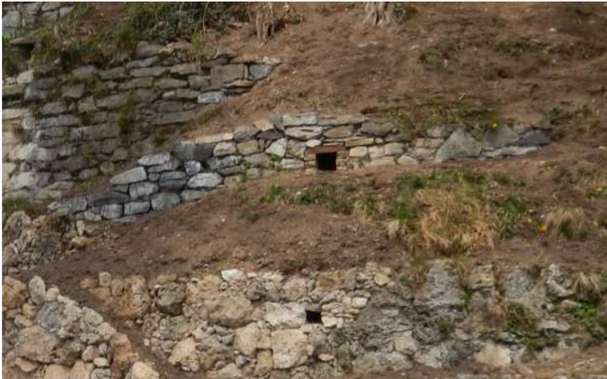
Ergänzte Kalksteinmauer in Sichtbauweise mit Öffnung des Wasserkanals.
