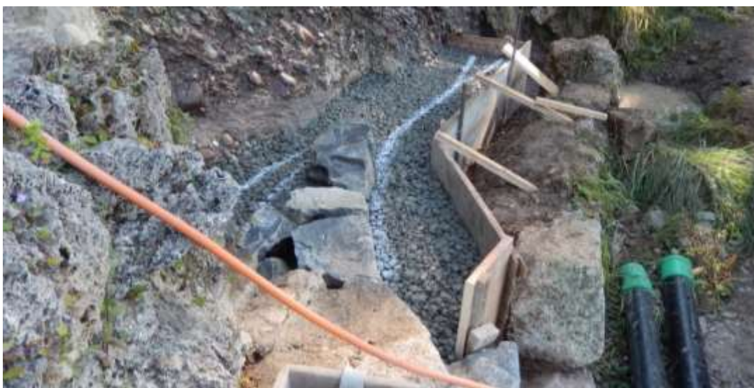
Fundament aus Sickerbeton.
