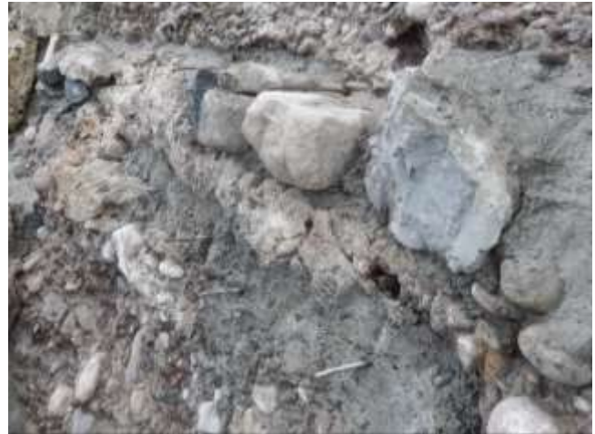
Schroff gemauert, damit der Tuff gut befestigt werden kann(l), Auflager für die mittlere Mauer(r).
