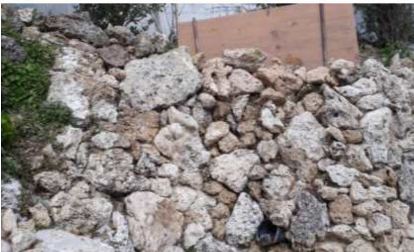
Erhöhung der obersten Mauer um die Auswaschungen ins Wasserbecken zu vermindern.
