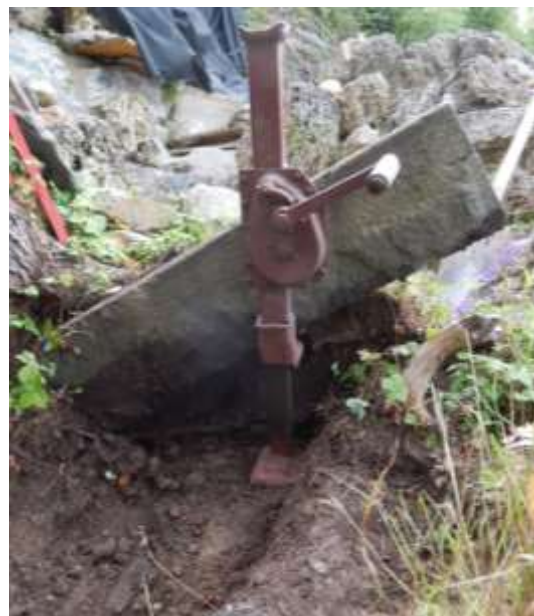
Eingemessene Treppentritte werden ausgebaut und zur Wiederverwendung deponiert.
