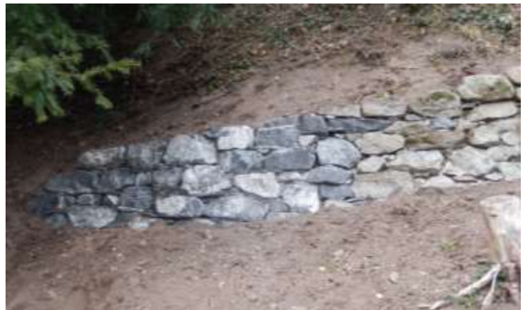
Neu erstellte Stützmauer bei der Treppe (l), der hergerichtete Mauerflügel optisch am Bestand angeglichen (r).
