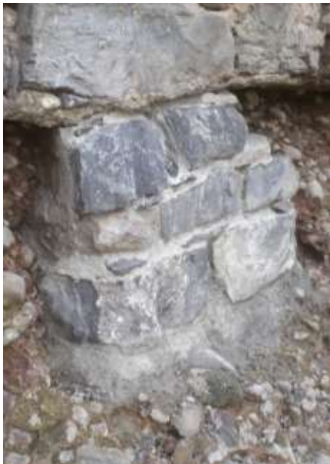
Erste stützende Untermauerung, fertige Unterfangung mit Wasserdurchlässen.
