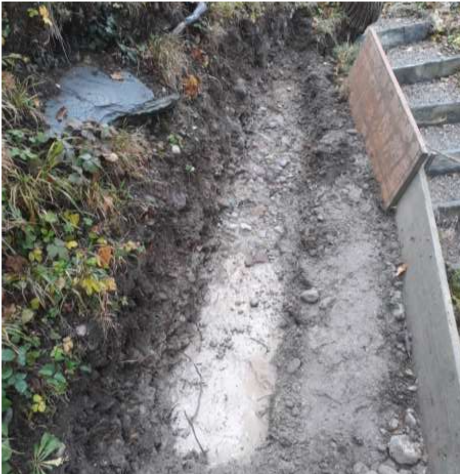
Aushub auf die Nagelfluh für die neue Kalksteinmauer beim Treppenlauf
