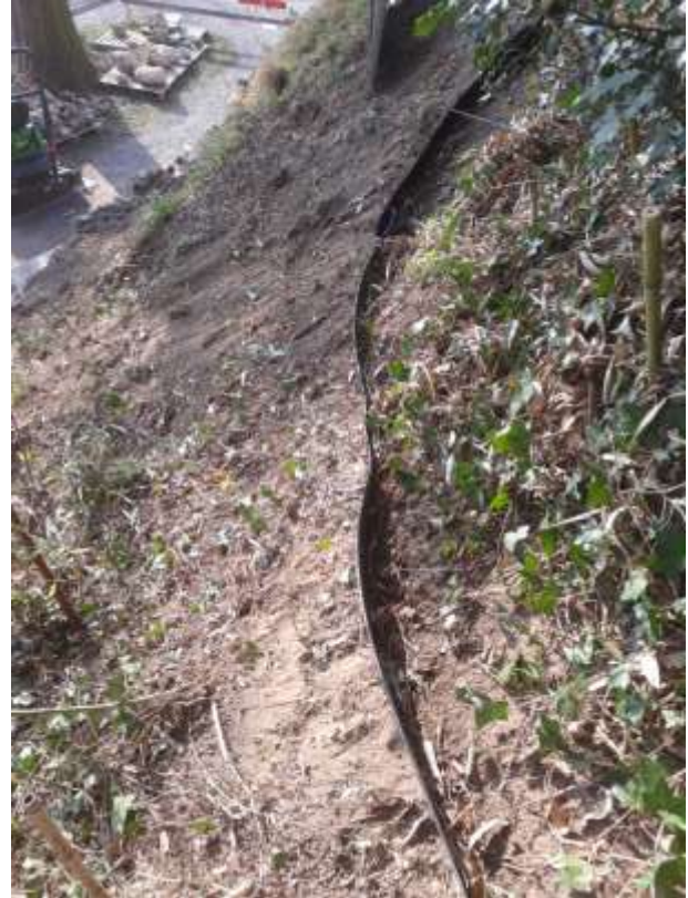
An Seilen gesichert wird der Bambus entfernt(l), eingelassene Rhizomsperre(r).
