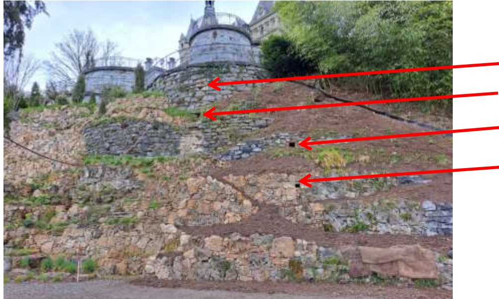
Vorhandene und freigelegte Wasserauslässe
