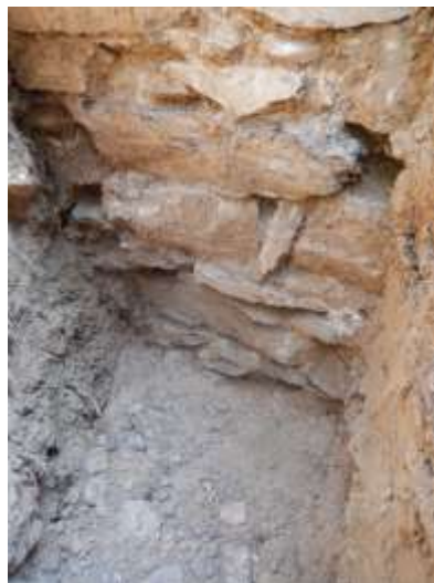
Widerlager aus Magerbeton, freigelegte Gewölbewand und Eisenverbinder in die Nagelfluh.
