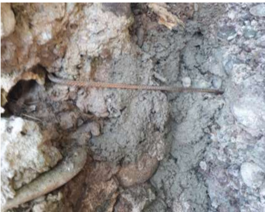
Mit Mörtel geklebtes Mauerende mit zusätzlichem Metallanker.
