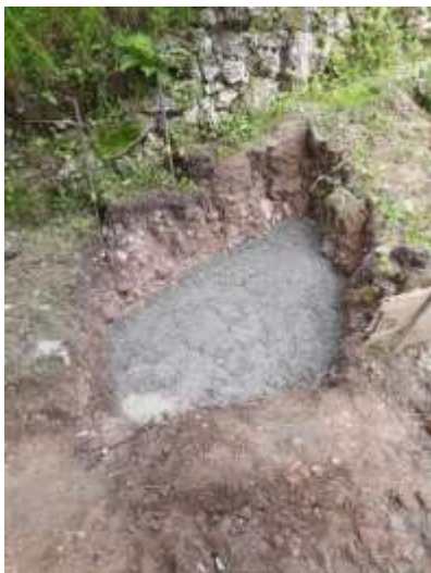
Widerlager aus Magerbeton, freigelegte Gewölbewand und Eisenverbinder in die Nagelfluh.
