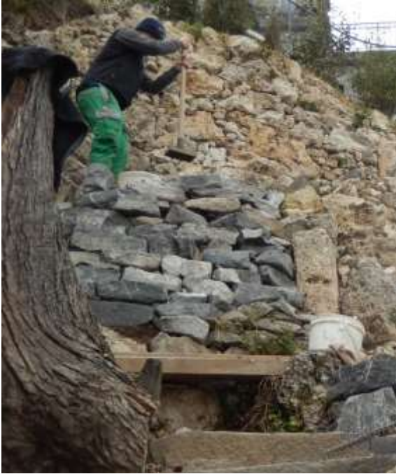
Erhöhung der Trockenmauer bei der Treppenkehre.
