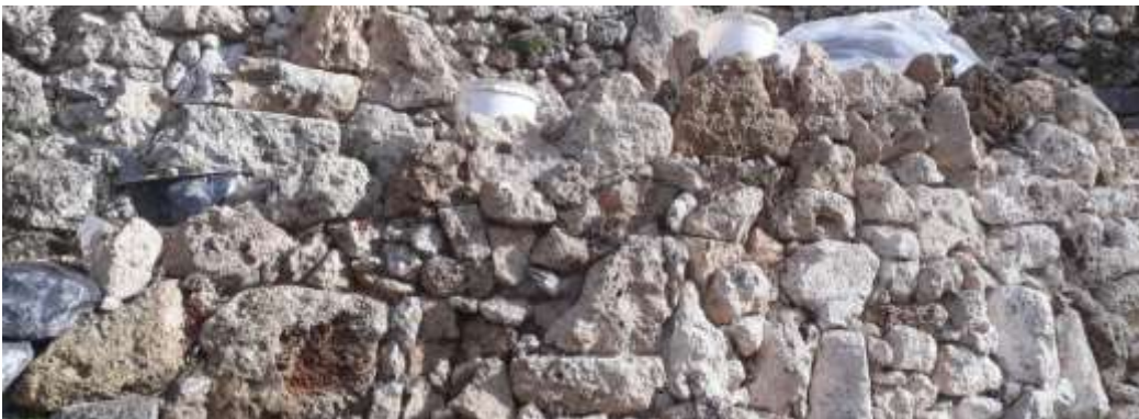
Kaschierung der Treppenstufen über dem Gewölbe.
