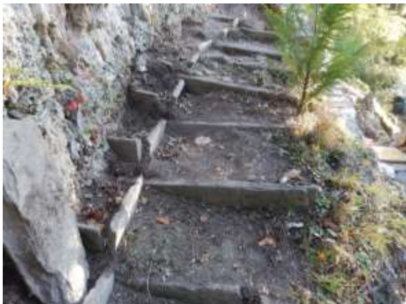
Freigelegte Treppe mit erhöhten Rabatten, Mauerende auf der Nagelfluh.
