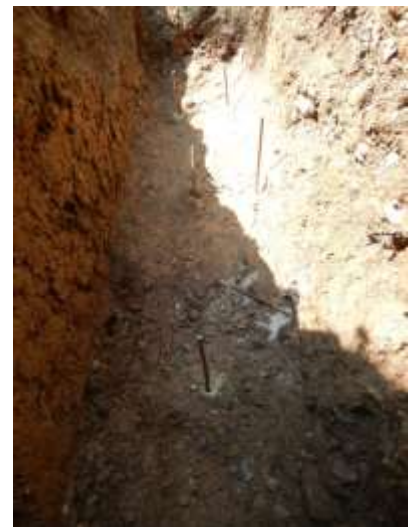
Widerlager aus Magerbeton, freigelegte Gewölbewand und Eisenverbinder in die Nagelfluh.
