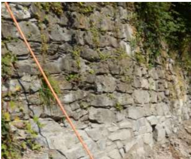
Als Vorbild dienende Mauer (l), neu erstelltes Mauerstück (r).
