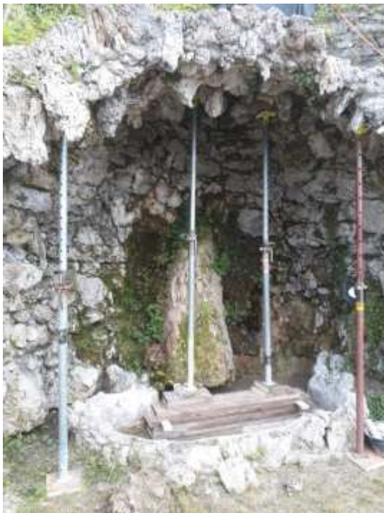
Abgestütztes Gewölbe: vertikal und seitlich
