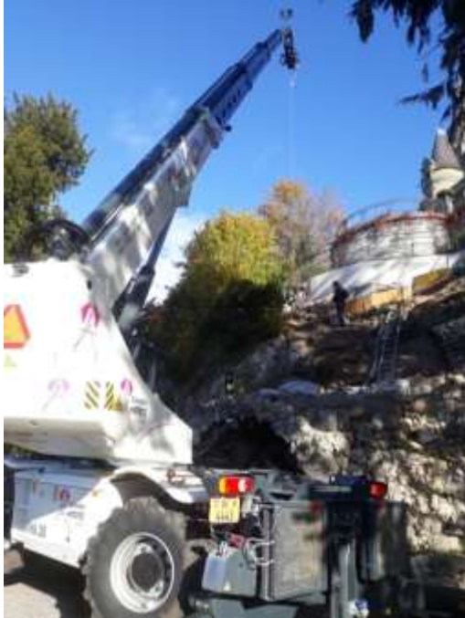
Teleskopkran im Einsatz, deponierte Tuffsteine am oberen Wegrand
