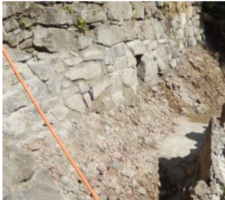
Erste stützende Untermauerung, fertige Unterfangung mit Wasserdurchlässen.
