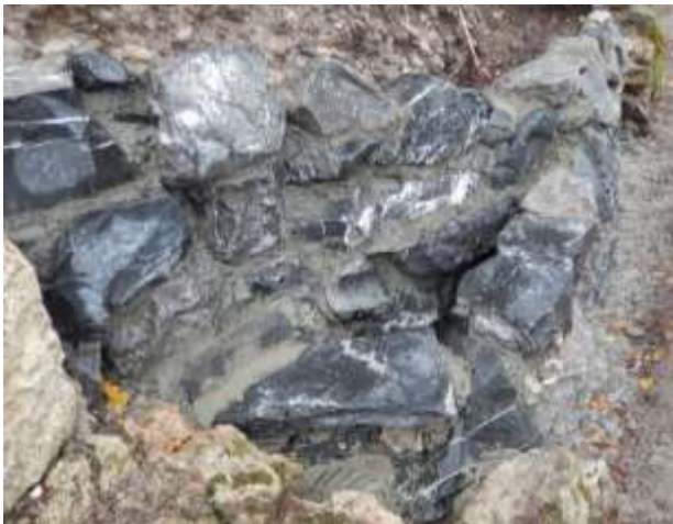
Schroff gemauert, damit der Tuff gut befestigt werden kann(l), Auflager für die mittlere Mauer(r).
