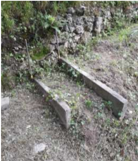
Eingemessene Treppentritte werden ausgebaut und zur Wiederverwendung deponiert.
