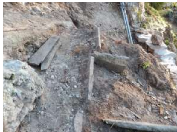
Freigelegte Treppe mit erhöhten Rabatten, Mauerende auf der Nagelfluh.
