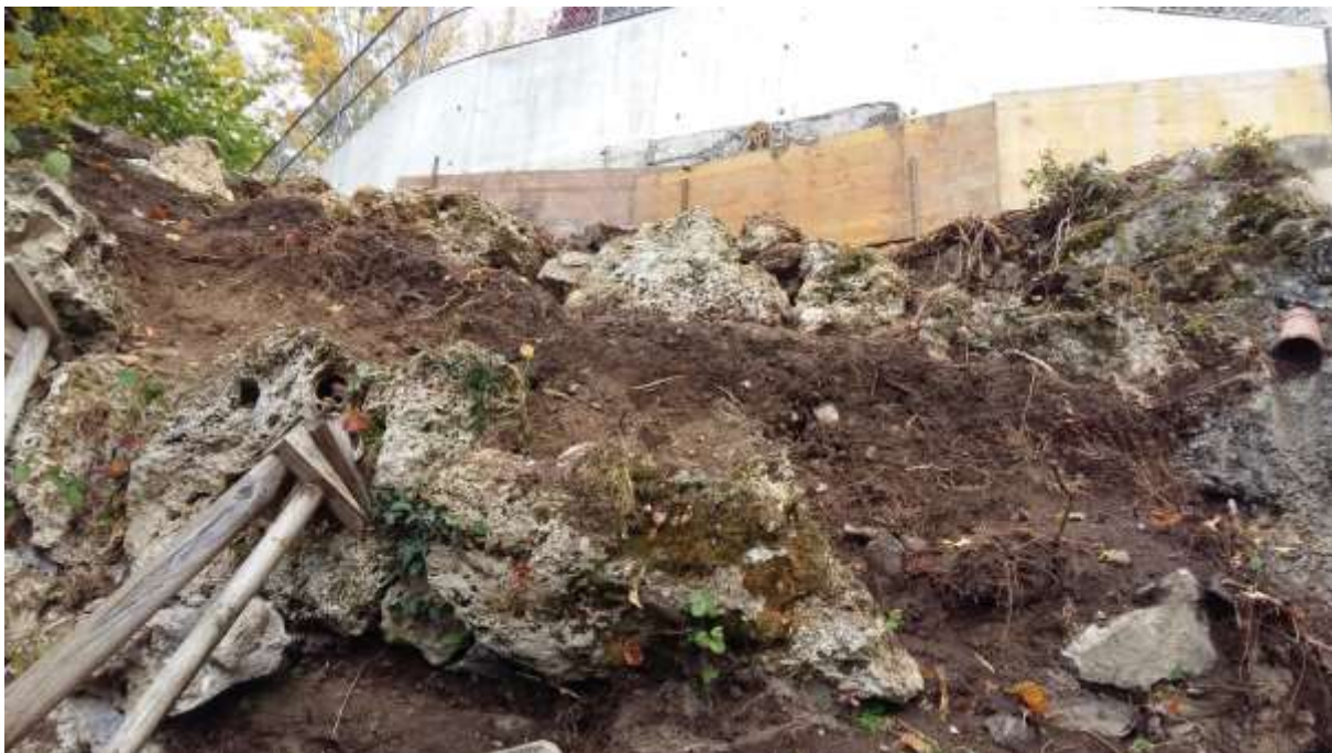
Zustand unterhalb neuer Betonmauer vor der Restaurierung Böschung
