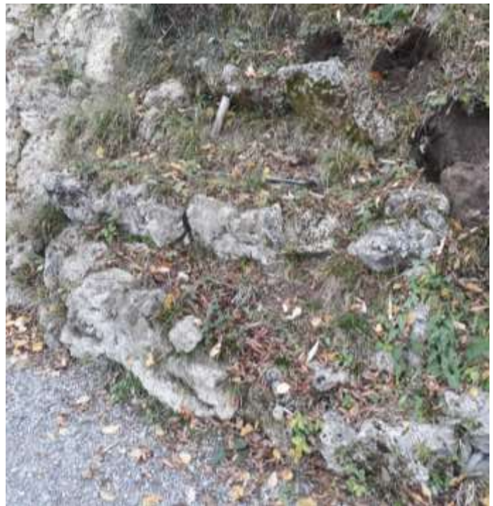
Vorzustand: Grasböschung mit Mauerstücken (l), gerutschte Mauerstücke am Böschungsfuss (r)
