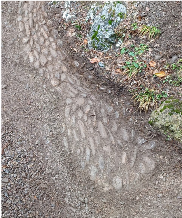
Abschnitt oberhalb der Gesteinsformation, Verlegerichtung weist über den Weg (evtl. Abschlag).
