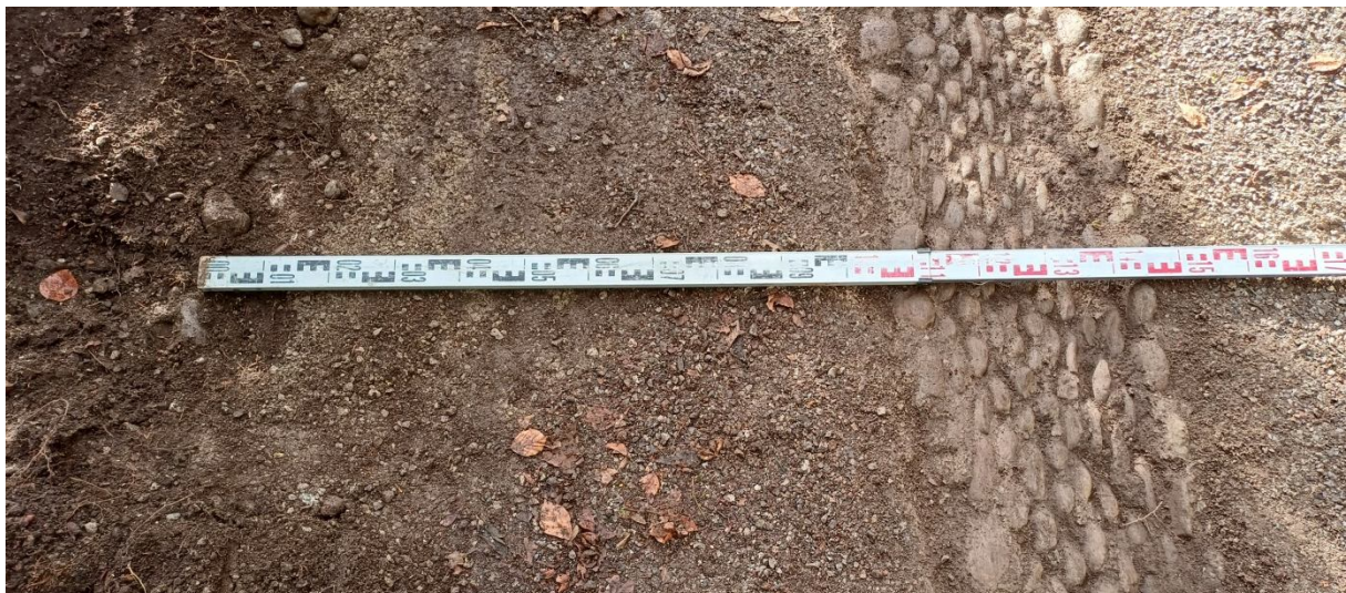
Wegbreite mit Wasserschale im oberen Sektor ca. 1,4m. bis 1,5m.
