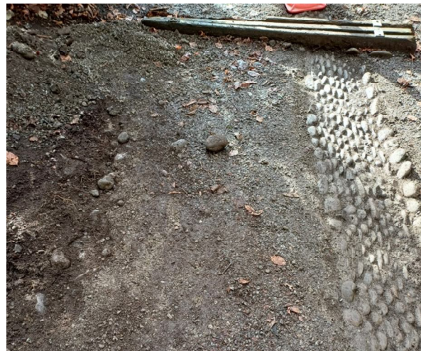
Freigelegtes oberes Ende (l) sichtbare Kofferung auf der Hangseite (r).
