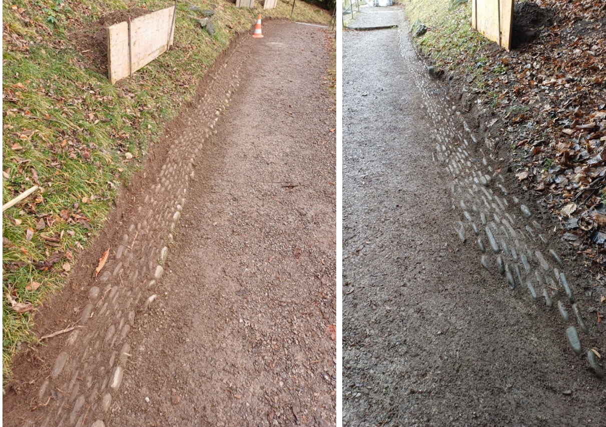
Freigelegte Wasserschale, abgestochener Böschungsfuss.
