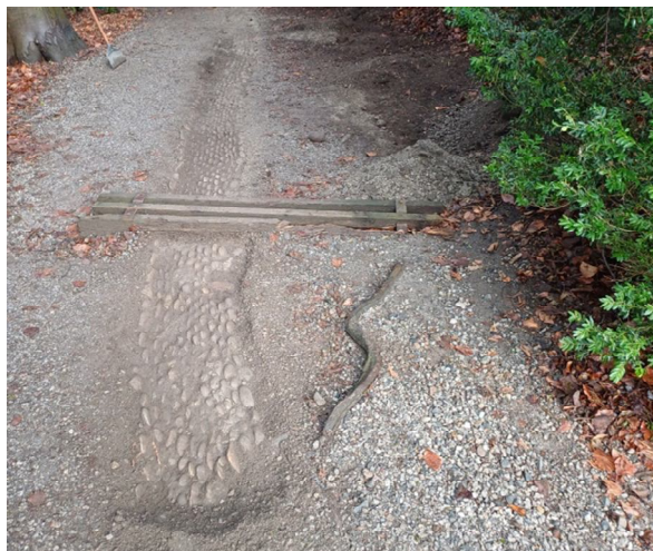
Freigelegtes oberes Ende (l) sichtbare Kofferung auf der Hangseite (r).
