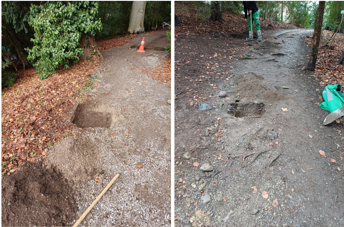
Sondierlöcher in der Fortsetzung: oberhalb kein Befund (l), unterhalb Pflästersand (r).
