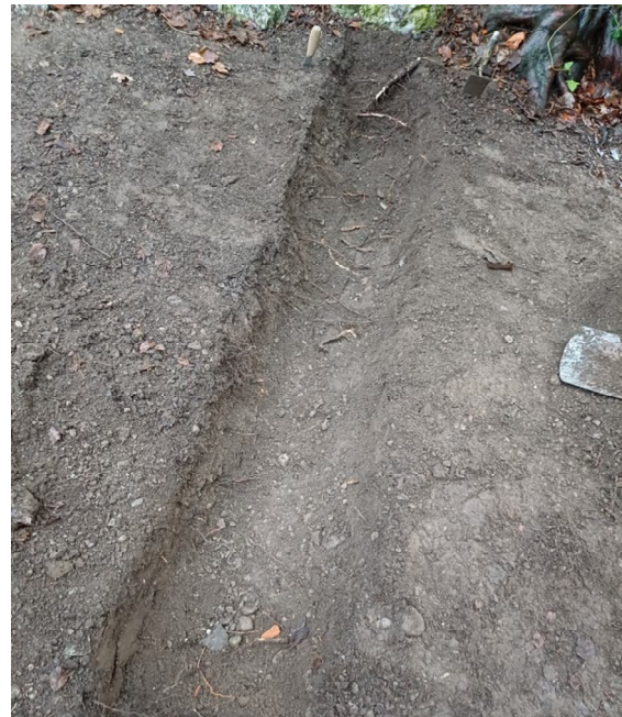
Gefundene Kofferung in der Verlängerung bestätigt Lage nach historischem Plan.
