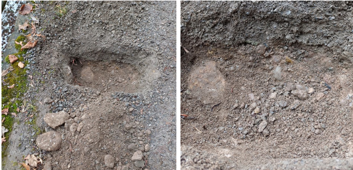
Koffering bis an die Mauer (l), Kiesiges Koffermaterial bis max. 10cm Durchmesser (r).
